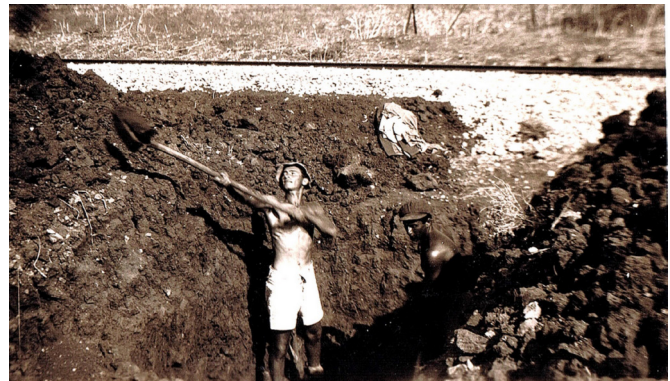
העברת צינור המים מתחת פסי הרכבת בקו המים מכפר יהושע להזורע 1940-1941
